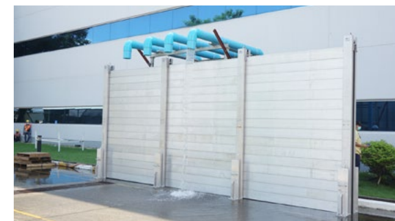
止水壁の組み立て訓練
